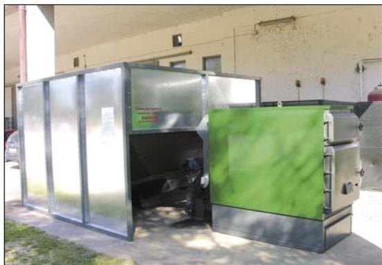
Foto 4 - Caldaia con serbatoio per il cippato installata presso l'ISMA.
