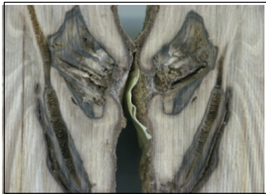
Porzione di legno degradato
